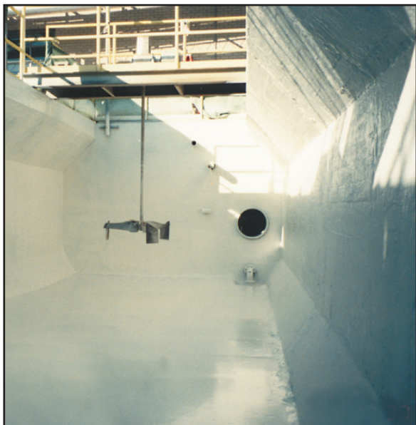
Aplicación completa de ChemLine® primer sobre superficie de concreto
